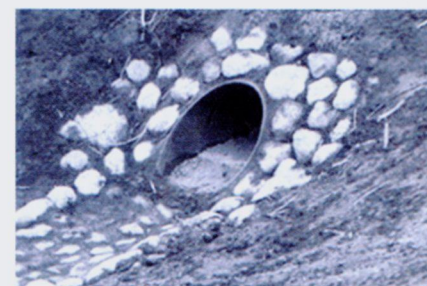
Фото 3. Вход в тоннель для прохода мелких животных через дорогу
